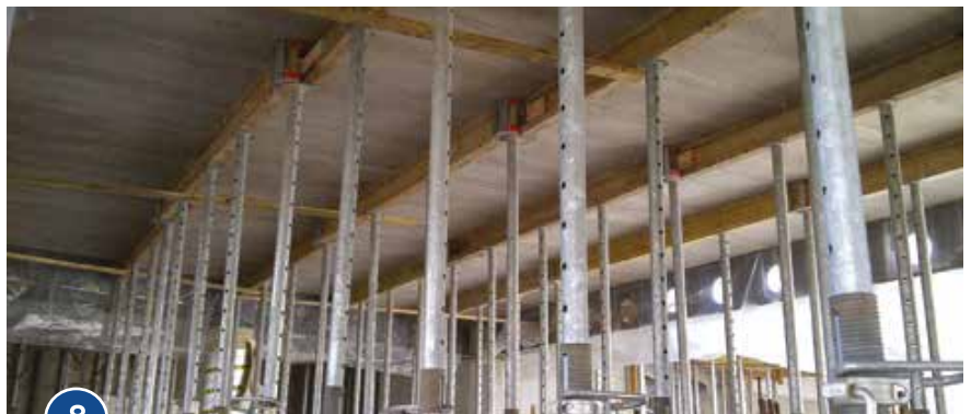
8 Tháo dỡ coppa sau khi bê tông đạt cường độ.
