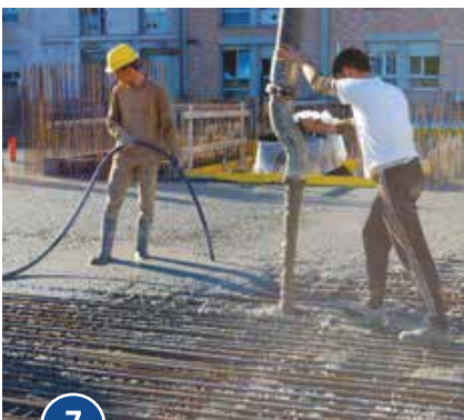
7 Thi công đổ bê tông lớp 2 hoàn thiện bề mặt bảo dưỡng theo quy định.
