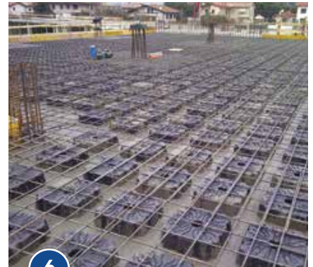
6 Thời gian chờ đổ bê tông lớp 2 đủ để bê tông lớp 1 se cứng.
