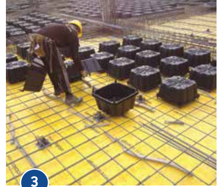
3 Lắp đặt hộp NEVO
