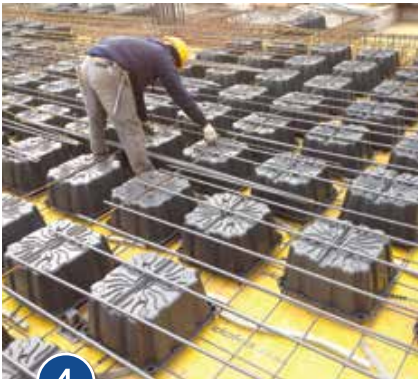
4 Thi công hoàn thiện cốt thép và các chi tiết kỹ thuật chờ sẵn.
